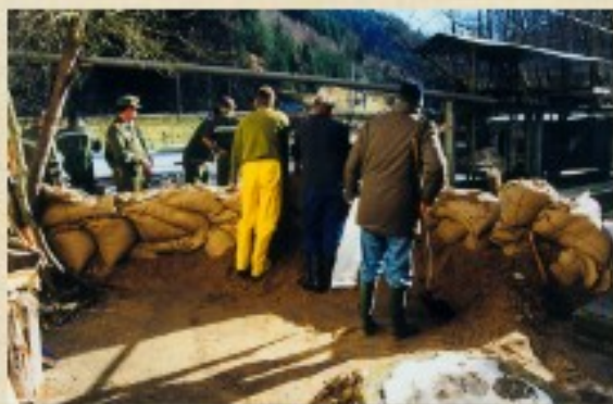
Hochwasserschutz bei Eisstoß
